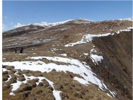
K1702+000 弃渣场，渣场边坡无任防护措施，应及时修建挡土墙，对渣场顶部平整后撒播草籽绿化。
