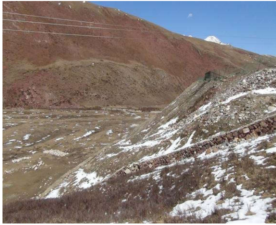
K1715+000 弃渣场，修建了干砌石挡土墙，部分已经损坏，建议及时对损坏的挡土墙进行修补。
