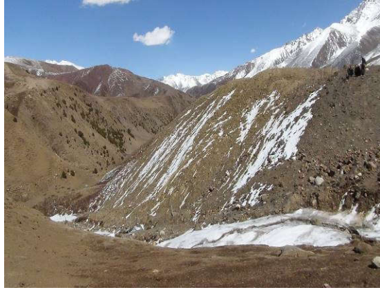
K1696+000 弃渣场，无任何防护措施，应及时修建挡土墙，排水沟，对渣场顶部平整后撒播草籽绿化。
