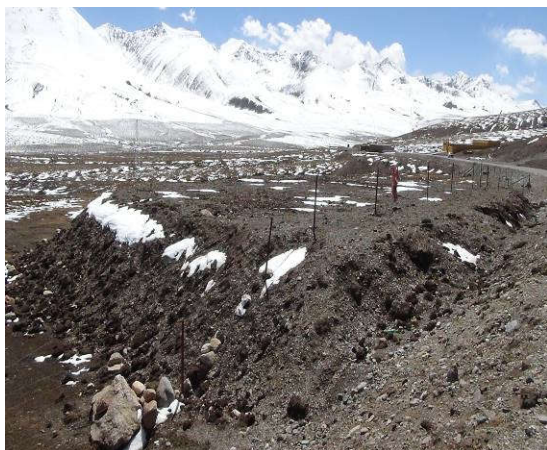
K1706+600 两处弃渣场，渣场边坡无任防护措施，应及时修建挡土墙，对渣场顶部平整后撒播草籽绿化。
