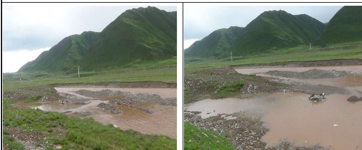
K1723+700 路左 10m 渣场，建议及时平整，并对渣场边坡修建浆砌石挡土墙。
