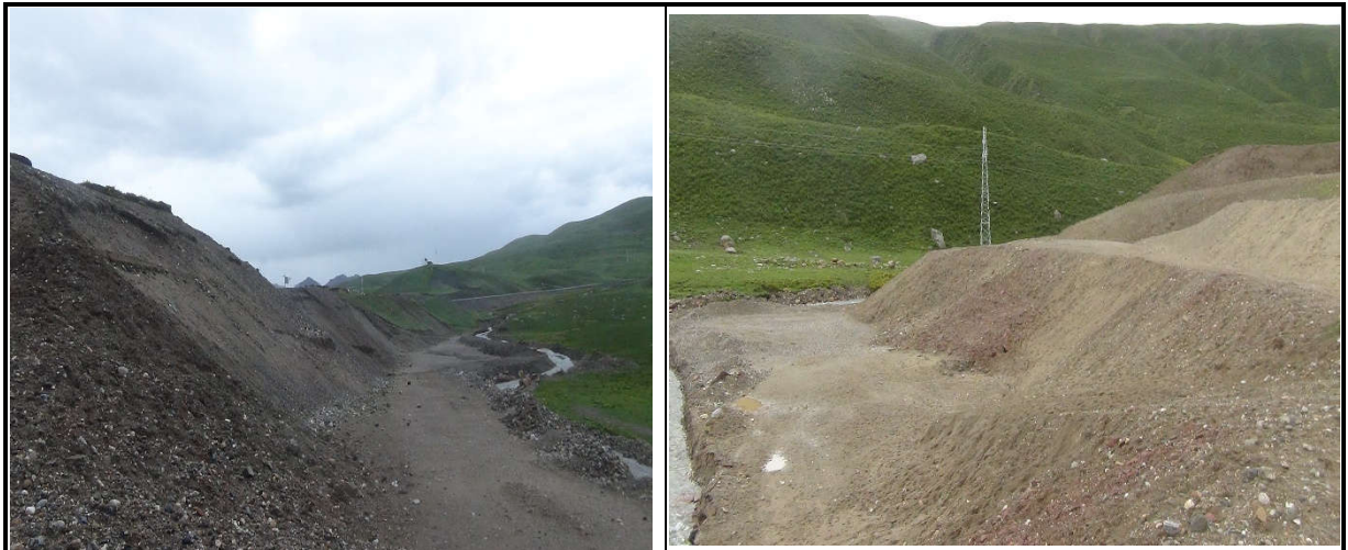
K1711+050 路左砂料场堆放场，及时平整河道及河滩地，并撒播草籽绿化。
