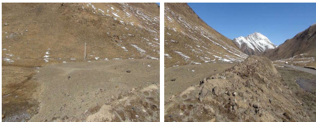
K1670+800 左侧 20m 弃土场，及时修建挡土墙，撒播草籽绿化。
