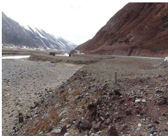
K1723+200 弃渣场，无拦挡措施，应及时修建挡土墙，并对渣场撒播草籽绿化。
