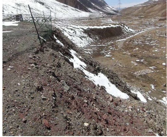
K1715+000 弃渣场，修建了干砌石挡土墙，部分已经损坏，建议及时对损坏的挡土墙进行修补。
