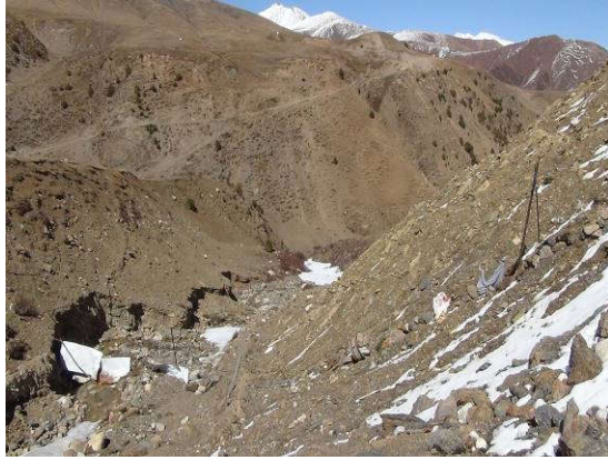
K1696+000 弃渣场，无任何防护措施，应及时修建挡土墙，排水沟，对渣场顶部平整后撒播草籽绿化。
