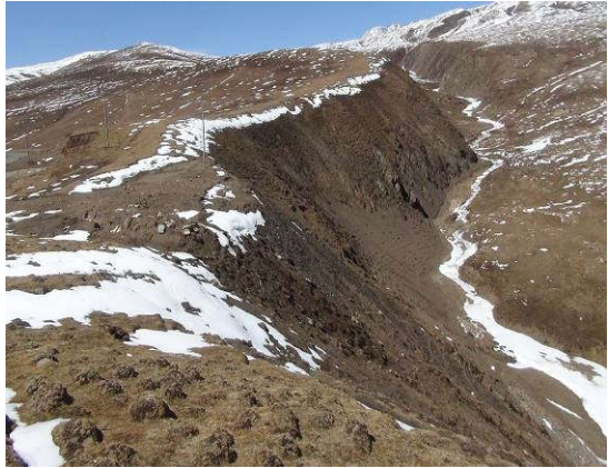
K1702+000 弃渣场，渣场边坡无任防护措施，应及时修建挡土墙，对渣场顶部平整后撒播草籽绿化。
