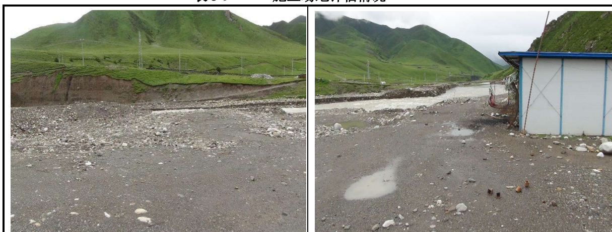
K1653+100 右幅碎石加工场地, 土地整治后覆土以撒播草籽绿化。
