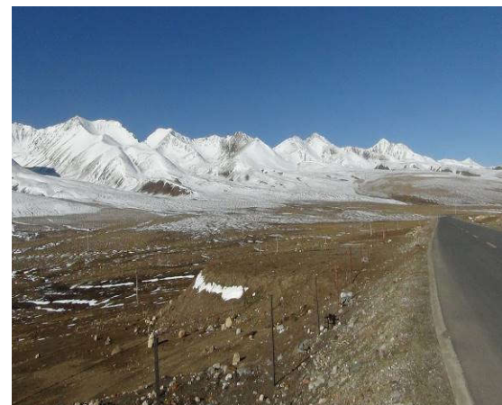
K1706+600 两处弃渣场，渣场边坡无任防护措施，应及时修建挡土墙，对渣场顶部平整后撒播草籽绿化。
