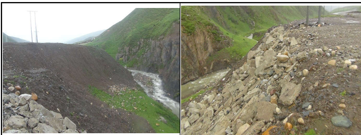
K1700+000 路右 50m 弃渣场，渣场坡度较陡，建议对渣场进行分级防护，及时修建浆砌石挡土墙，覆土以撒播草籽绿化。
